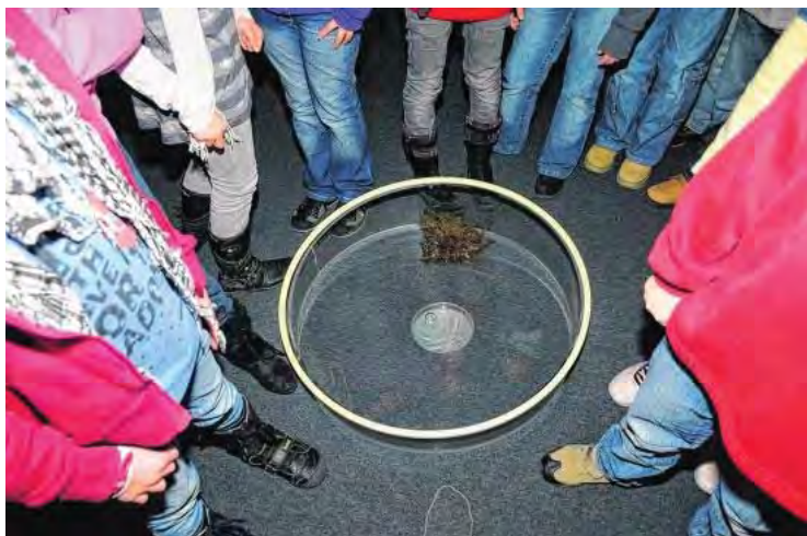
Das "Loch" in der Kunsthalle, die Künstlerin Nathalie Braun Barends auf dem Dach des Gebäudes und die Anbringung des Sicherheitsglases.
